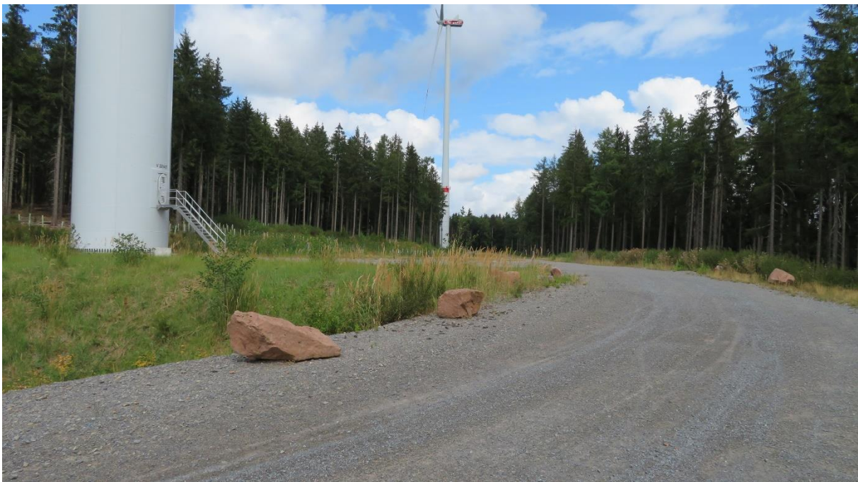
Bild 7: Wegebau und Geländemodellierung für Windkraftwerke auf dem Stillfüssel südlich Waldmichelbach
